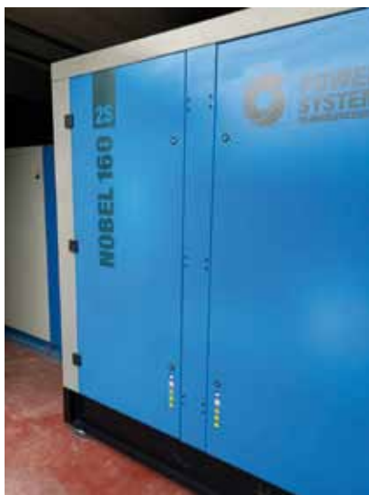
NOBEL 2S 160 DV, il compressore 160 kW bistadio Power System presso Novocart.
